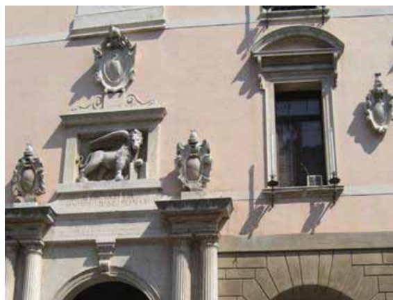
図3 歴代医学部教授献体の塗り込められた壁（外観）
